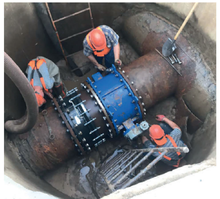
Процесс установки запорно-регулирующей арматуры
