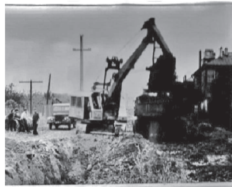
УСТРОЙСТВО ТРАНСИТНОЙ КОЛОДЕЦНОЙ Д-800 мм НА УЛ. БЕНДИНСКОЙ.
